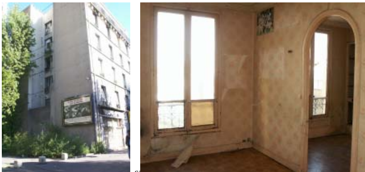
Figure 1 : Site d'étude : vues extérieure et intérieure
