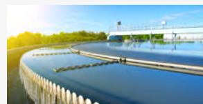
TRAITEMENT DES EAUX
